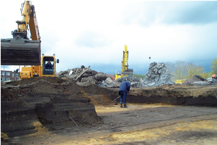
Afb. 4.2 Aanleg van een werkput in volle gang.
